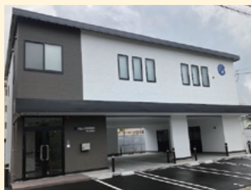
岡山営業所外観
