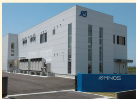
株式会社アムノス富山本社及び工場
