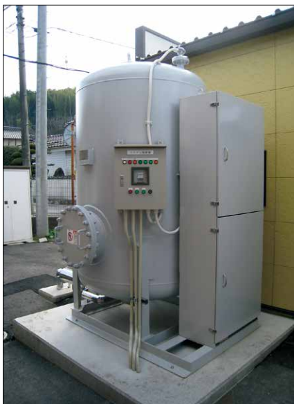
認知症対応型共同生活介護施設(広島県福山市) デイサービス・グループホーム太陽
