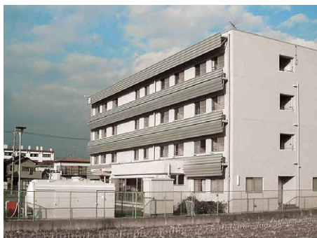
福祉施設(スプリンクラー設備)
